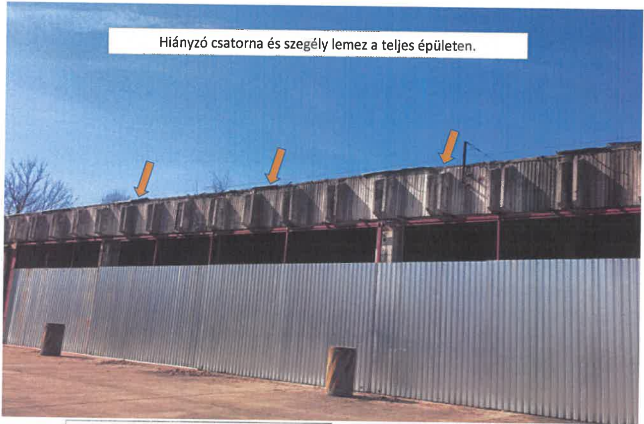
Levált, hiányzó szegély lemez a vizet nem tudja elvezetni az épülettől. A víz így szabadon hömpölyög az oldalfalon. Téli időszakban a beton felfagyását okozva.
