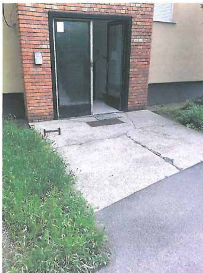
A lépcsőház előtti betonjárda
